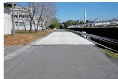
写真2 コンクリート舗装(白舗装)
