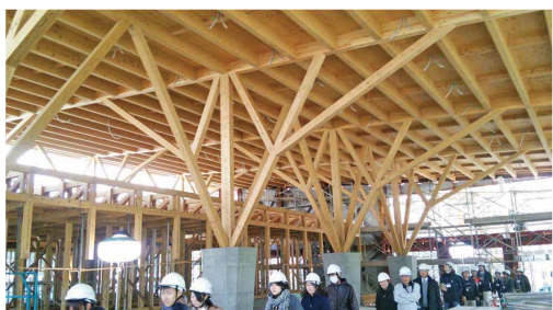
<写真 新学生食堂の内部空間(建設中)>
