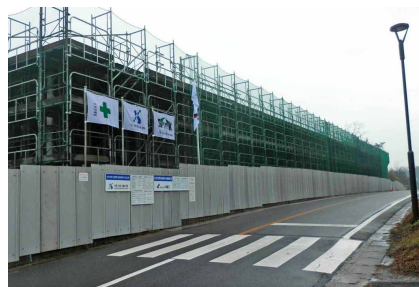
＜図3 工事中の外観＞
