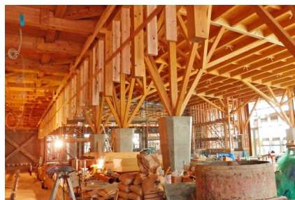
＜図1 工事中の福利厚生施設＞
